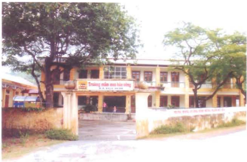
Trường mầm non Bán công xây dựng và đạt chuẩn quốc gia năm 2006
